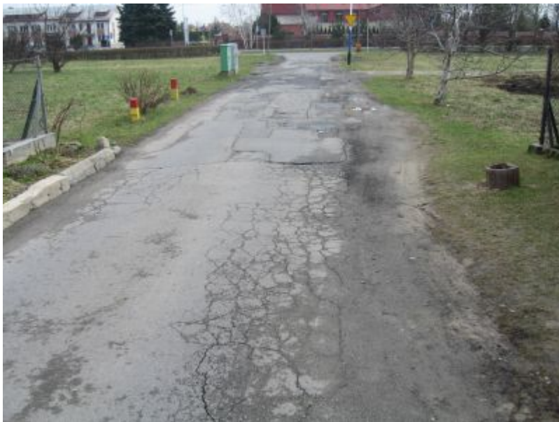
Fragment ul. Morgowej przeznaczony do przebudowy
