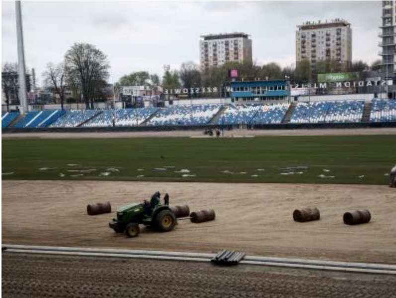
Układanie murawy na Stadionie Miejskim
