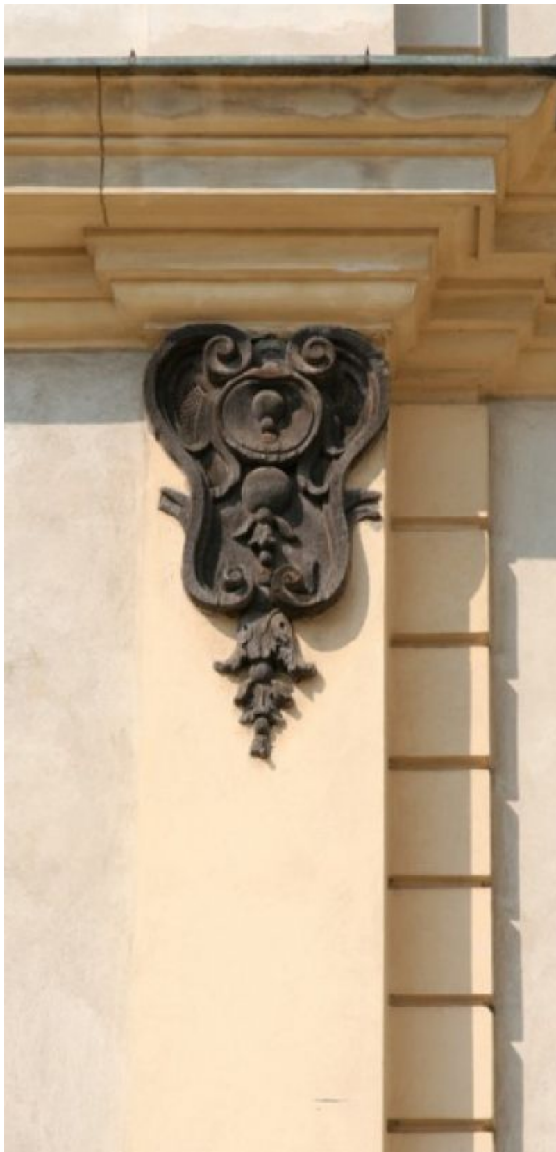
Detale architektoniczne elewacji pałacyku
