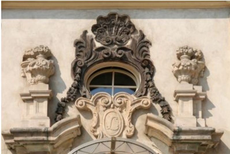
Detale architektoniczne elewacji pałacyku
