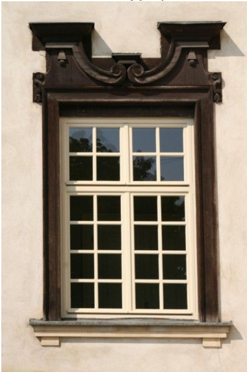
Detale architektoniczne elewacji pałacyku
