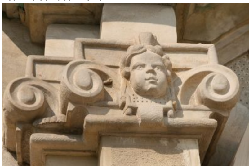
Detale architektoniczne elewacji pałacyku
